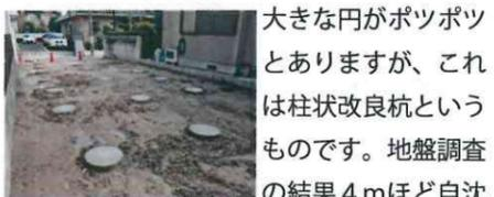
大きな円がポツポツとありますが、これは柱状改良杭というものです。地盤調査の結果4mほど自沈層が確認できたためにこのような杭を打って建物を支えます。W様邸は8月末の完成を目指してこれから工事を行います。光冷暖も搭載する予定です。
