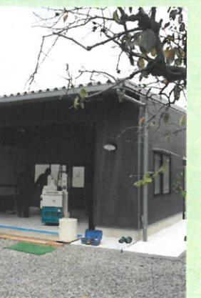
東広島市で農業用倉庫の新築工事を行っていたH様邸が完成致しました。倉庫は幅8m、奥行き5.1mの大きさを木造で建設しています。外壁には耐久性の高いガルバリウム鋼板を貼りました。内装は針葉樹合板の現し仕上げとなっているので、棚の増設など後からでも下地を気にせず自由に設置が可能です。きっと農作業の効率が今まで以上に向上すること間違いないです。
