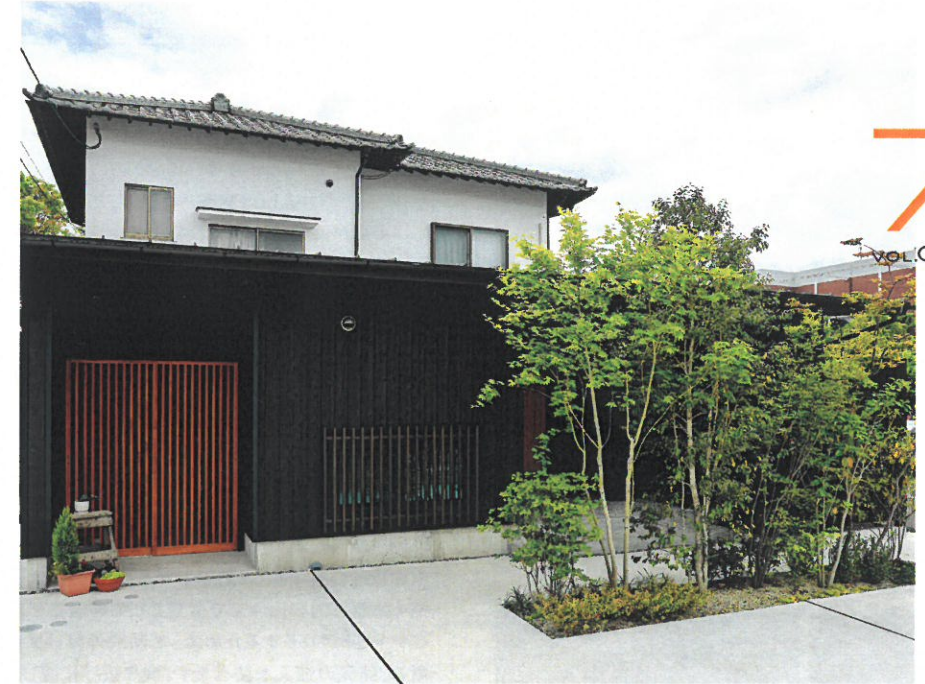
安佐南区K様邸 増築改修工事
