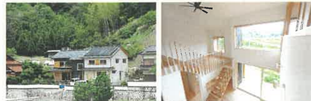
そとん壁と焼杉を採用した外観。石州瓦の屋根の一部には太陽光パネルを設置
