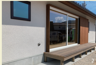
幅約3.5mのエクセルシャノンのサッシは戸袋にすっきりと納まり大開口を実現。
