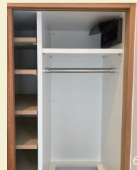
埋込ポストは気密性確保の為、下足箱内部に収納。
