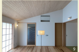
壁を凹ませ白いパネルを取り付けることで目立たせないエアコンに。
