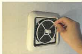
↑外の光が見えにくい状態 ↓つまみを持ってフィルターを取り外します
