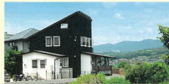
↑ 風通し抜群の外物干しデッキ。屋根をしっかりと出すことで突然の雨でも洗濯物が濡れてしまう心配がありません。また、リビングダイニングから見えない位置に配置し、来客時でも気兼ねなく洗濯物を干すことができます。洗濯脱衣室の隣に物干しデッキを設けて、洗う→干すの家事ラク動線を実現しています。
