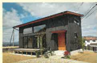
↑ 外壁に焼杉を採用した I 様邸。片流れ屋根でスタイリッシュな外観に。
