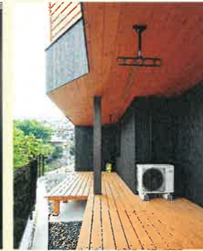
↑ 張り出した2階部分を屋根にしている外物干しデッキ。両サイドにある袖壁で周囲の視線が気になりません。約6.1mの横幅があり、大きな洗濯物もゆとりを持って干せる広さです。
