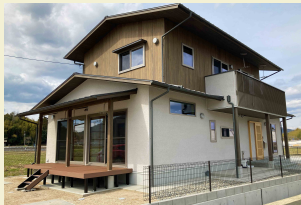
1階外壁はそとん壁のかき落とし仕上げ、2階の外壁は杉板+塗装でツートーンに。
