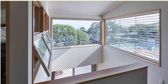
↑吹き抜けの西側に設けた窓に、外付けブラインドを設置。冬は全開にして日射を取得し、夏はルーバーの角度を調節しながら日差しをカット。室内のスイッチから手軽に操作できます。
