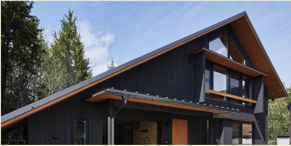
↑2階リビングの大きな窓の横に袖壁を設置。夏の朝日や夕日が室内へ入らないようにソフトでシュミレーションを行います。庇に簾を設置するとさらに快適空間へ。
