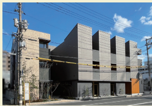
大通りから見た外観。1階と2階・3階のファサード構成を分けたシンプルな佇まい。
