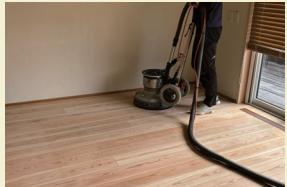
3回目の研磨後は細かく残っていた傷もより目立たなくなり、新築時のような床へと生まれ変わりました。最終工程では自然塗料を塗布し、無垢材ならではの風合いを残しながら表面の保護性能を高めています。
